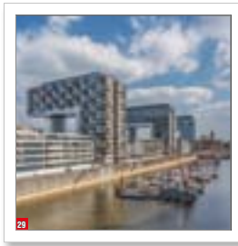
29 Rheinauhafen mit Kranhäusern und Hafenam
