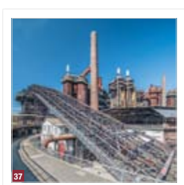
37 Völklingen - Völklinger Hütte, Hochofenanlage
