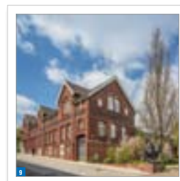
9 Kulturzentrum Kattwinkelsche Fabrik
