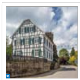
Fachwerkhaus in Dhünn
