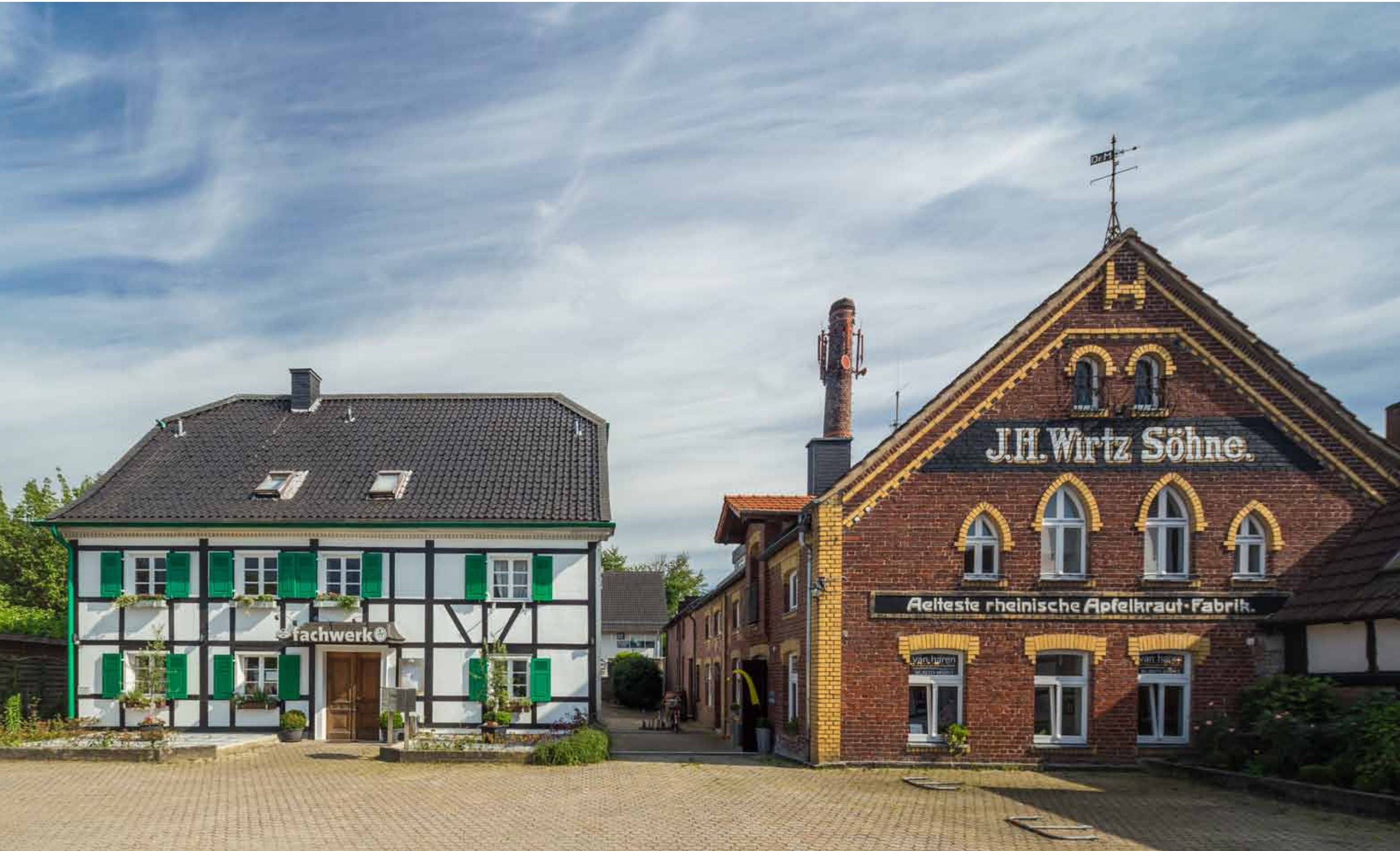
Ehemalige Rheinische Apfelkrautfabrik Wirtz & Söhne in Bergisch-Neunkirchen © Holger Klaes
