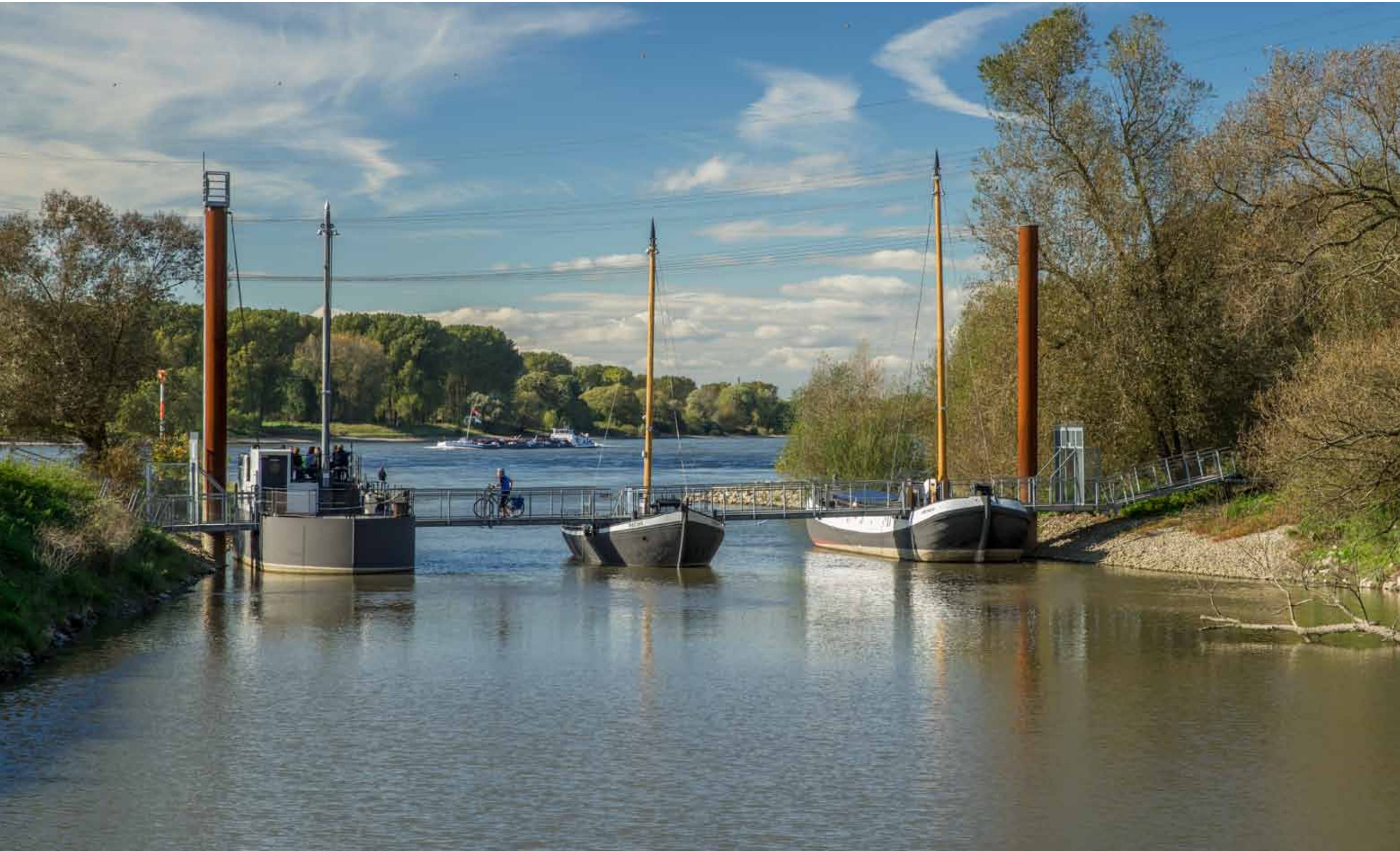
Schiffsbrücke Wupperrückführung in Rheindorf © Holger Klaes
