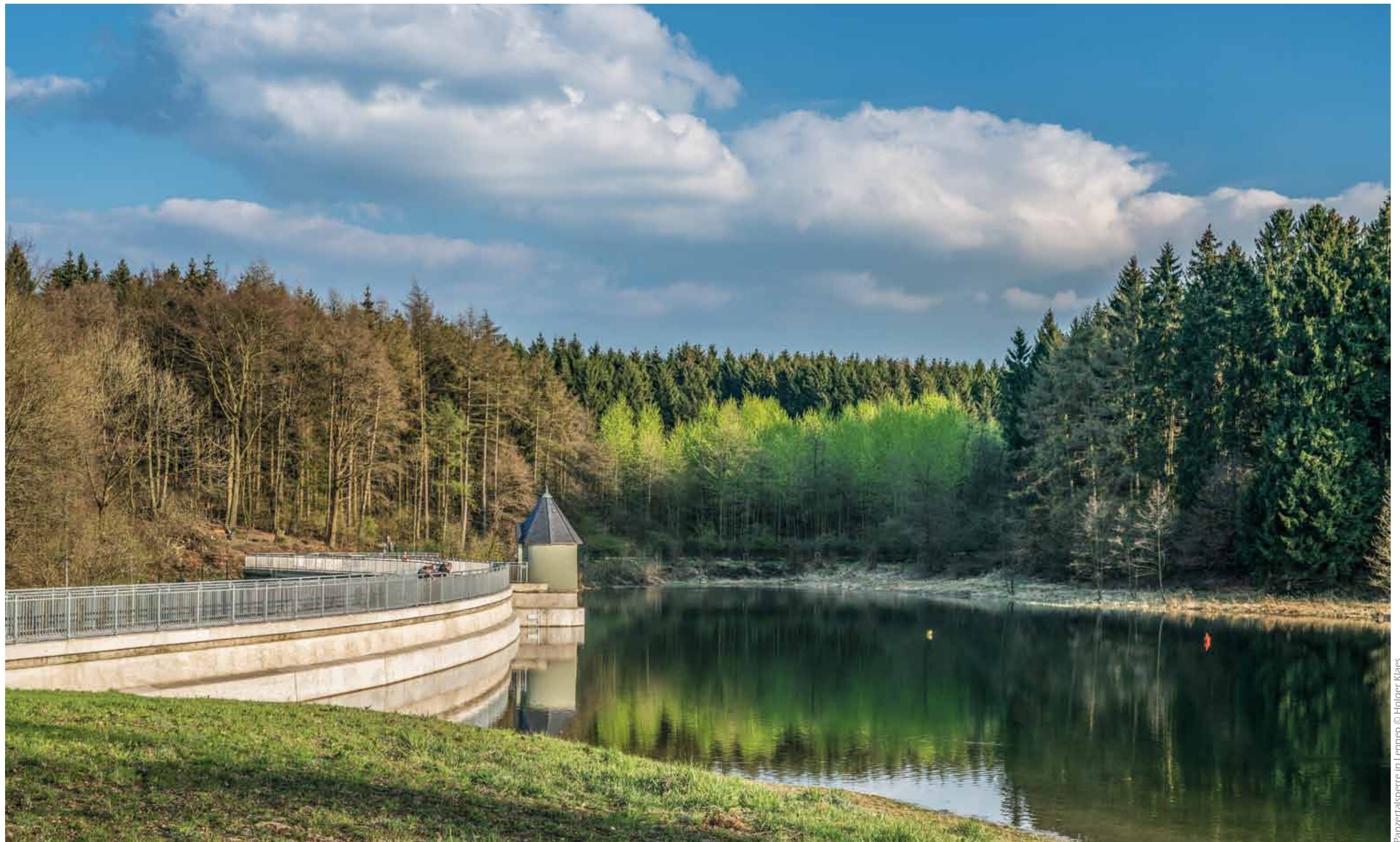
Panzertalsperre in Lennep © Holger Kläes
