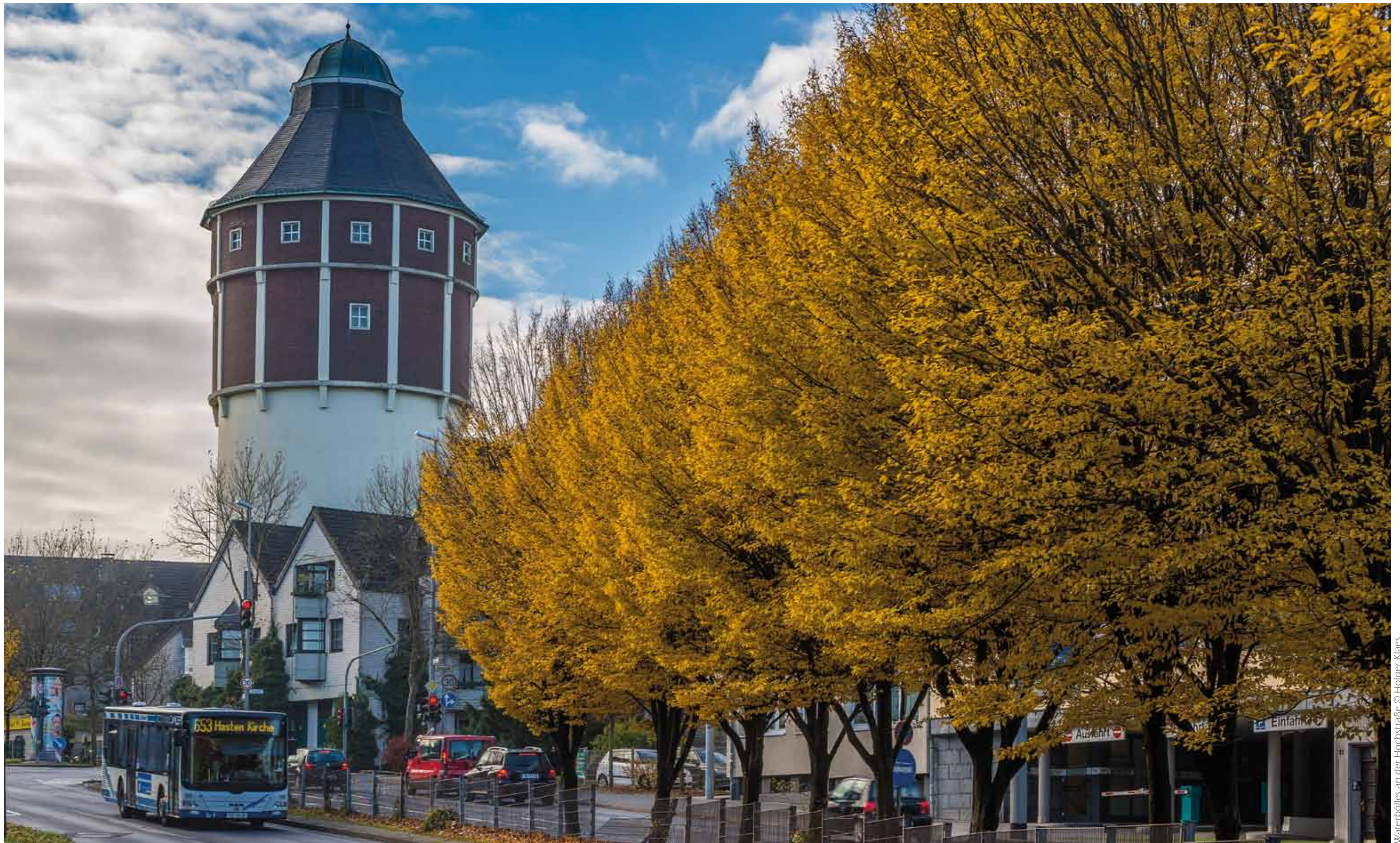
Waterböles an der Hochstraße © Holger Kläes
