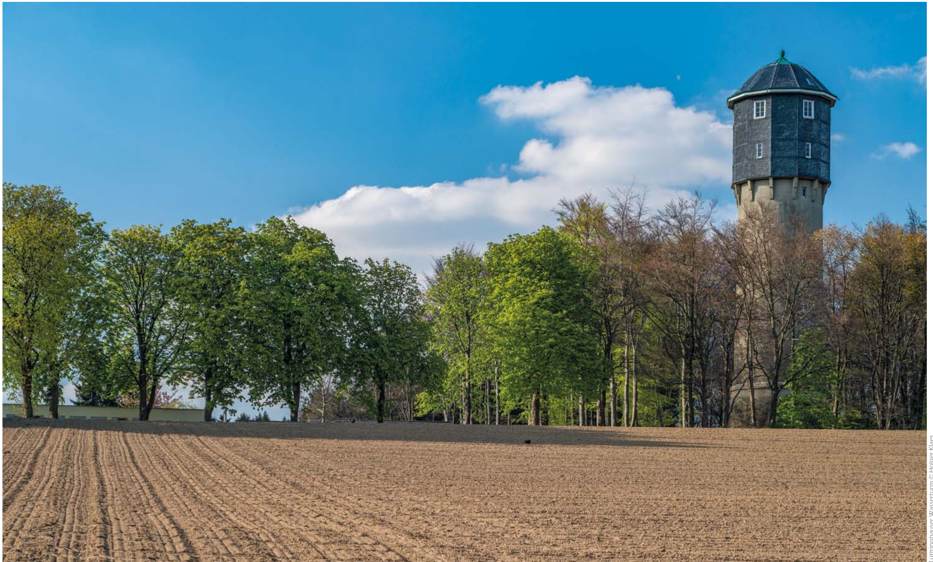
Lüttringhauser Wasserturm © Holger Klaes
