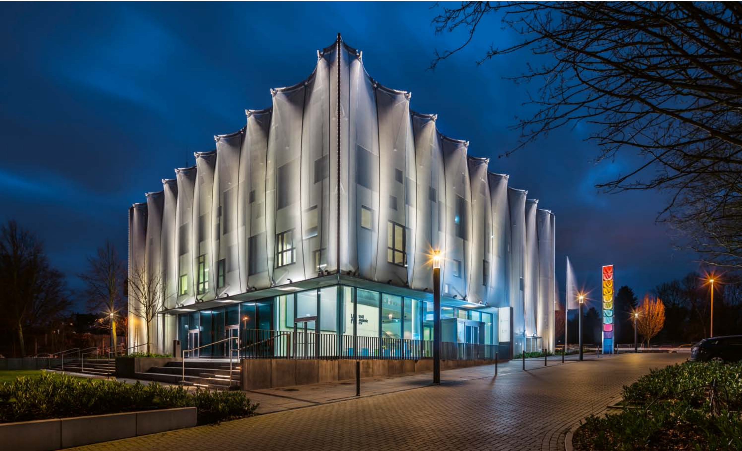
Erweiterungsbau der Textilakademie NRW mit Textilmembran [sop architekten und formTL] © klaes-images/Frank Laumen
