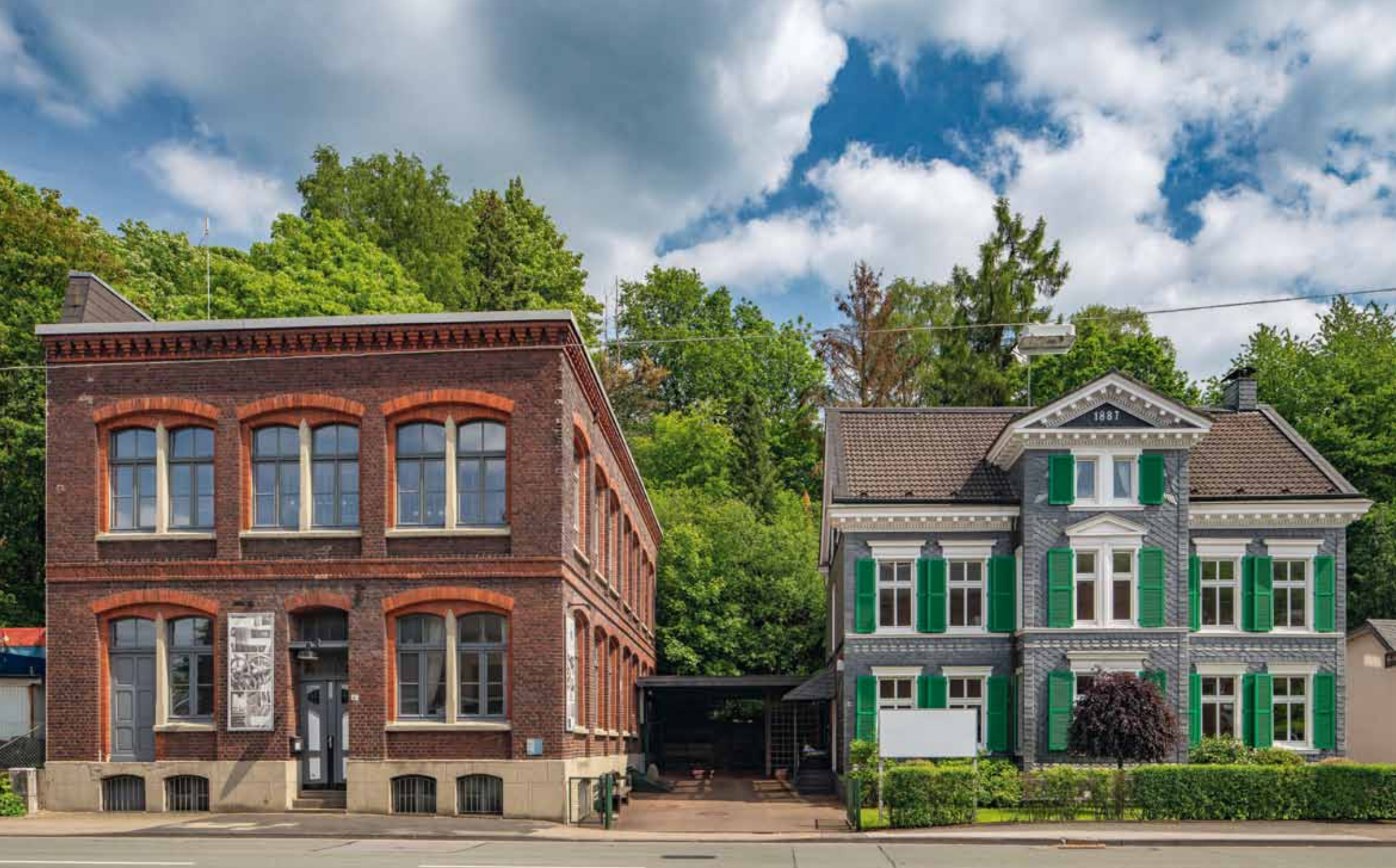
Bandweberei und Museum Kafka in der ehemaligen Bandfabrik Emil Kikuth im Stadtbezirk Langerfeld-Beyenburg © Holger Klaes
