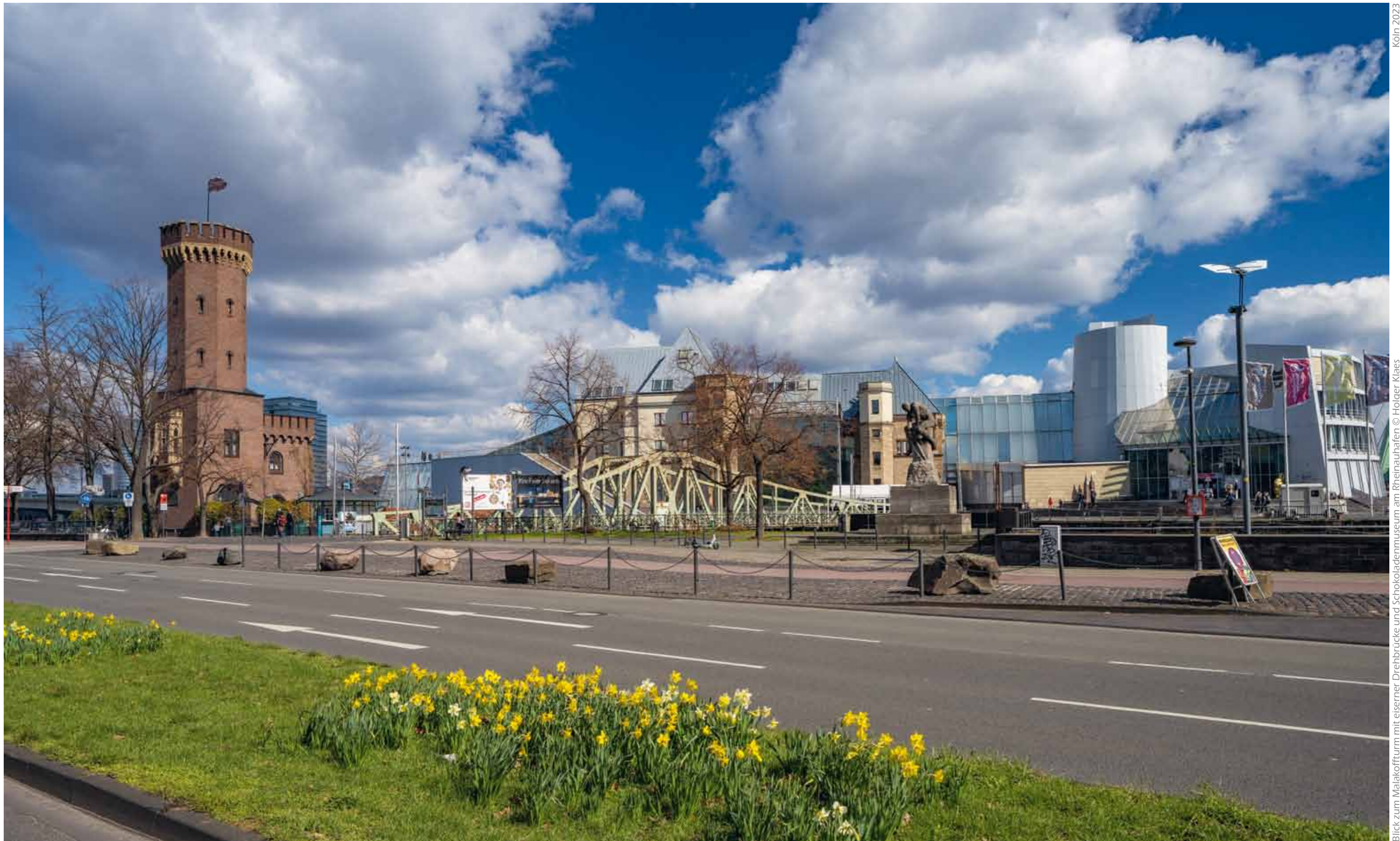
Blick zum Malakoffturm mit eiserner Drehbrücke und Schokoladenmuseum am Rheinufer © Holger Klaes Köln 2023
