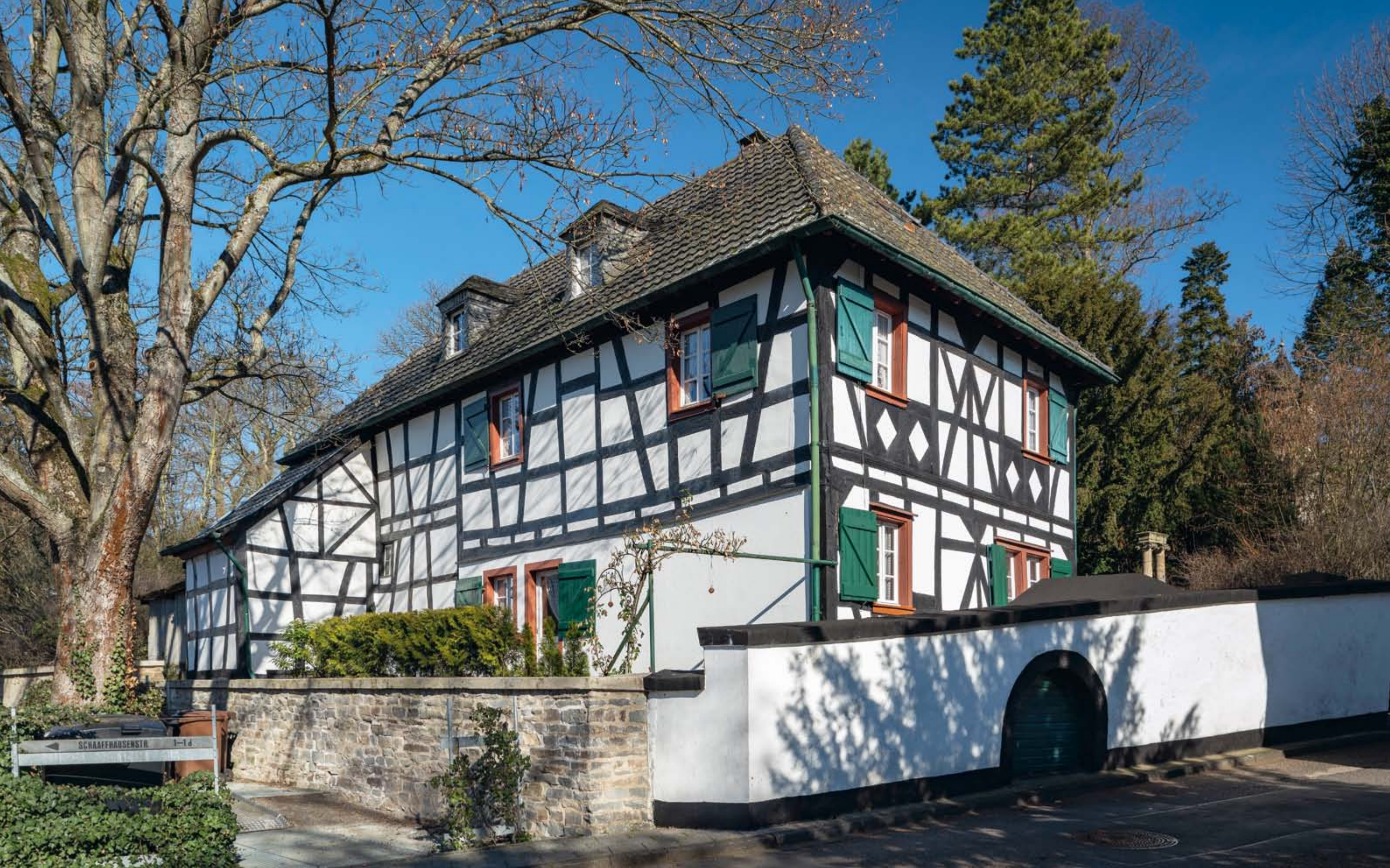
Siebengebirge - Historisches Fachwerkhaus von 1776 in Bad Honnef-Rommersdorf © Holger Klaes
