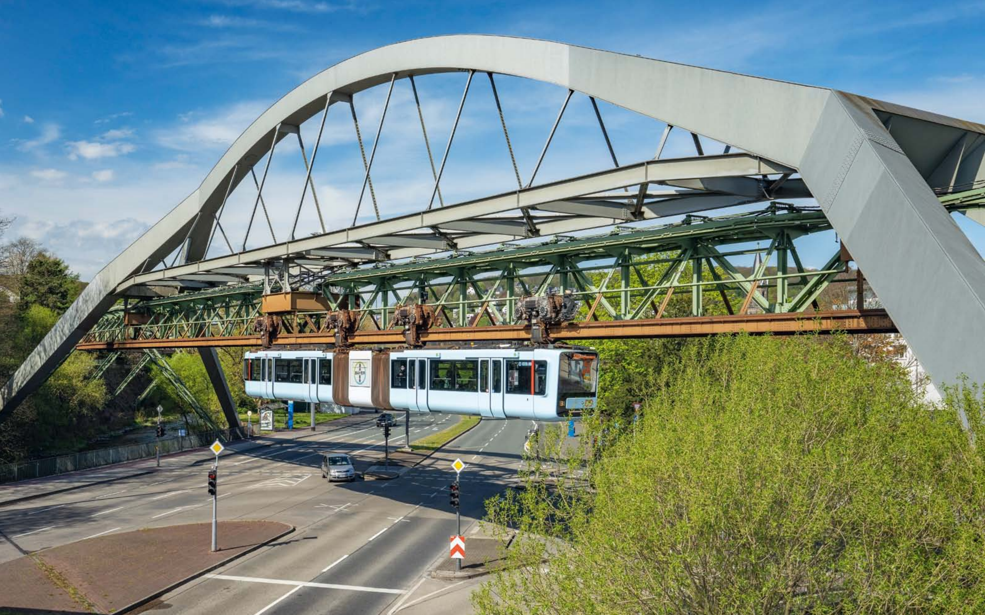
Wuppertaler Schwebebahn - Schwebebahnbrücke Bundesallee/Kasinostraße in Elberfeld © Holger Klaes
