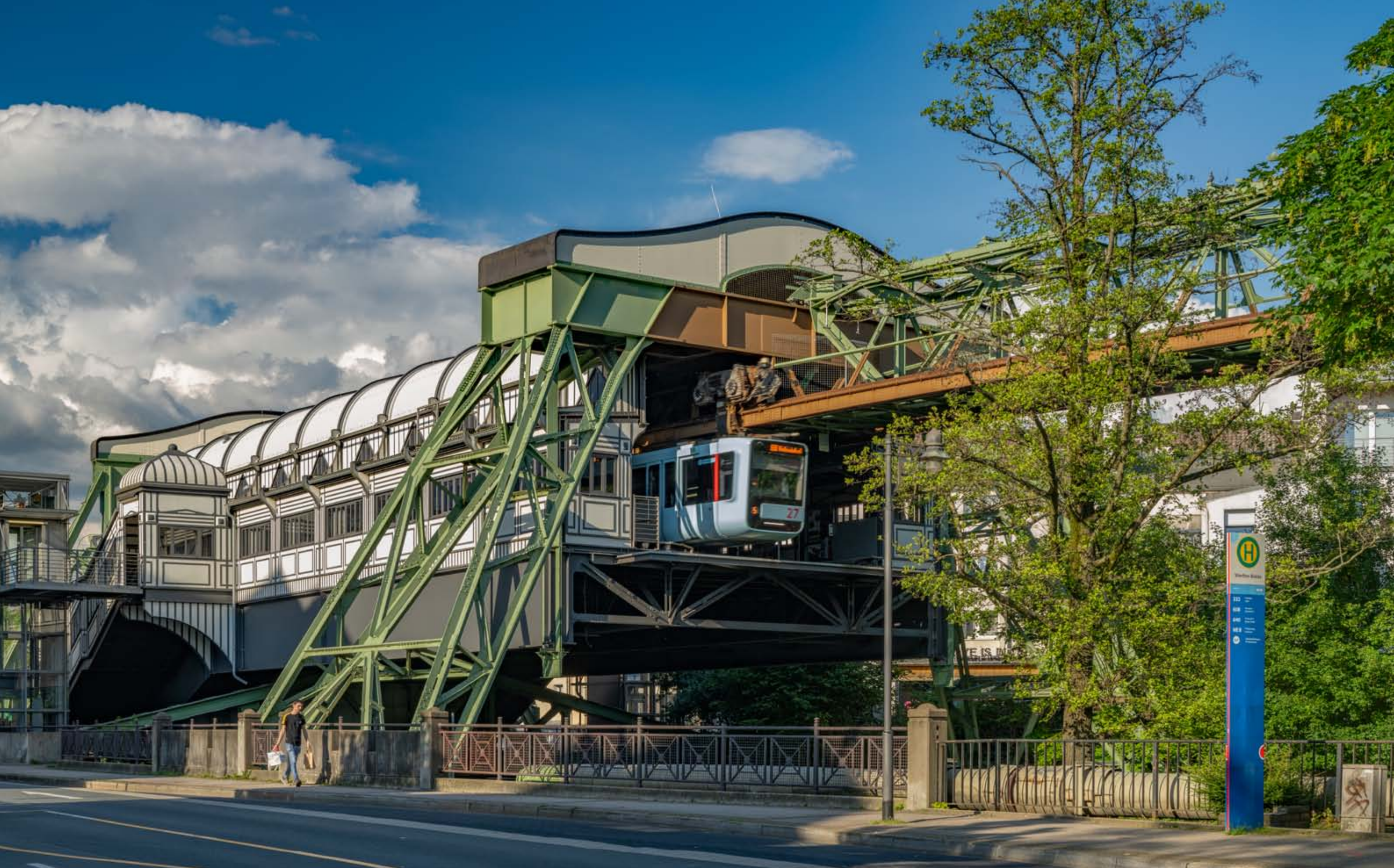
Wuppertal - Schwebebahnstation Werther Brücke © klaes-images/Holger Klaes
