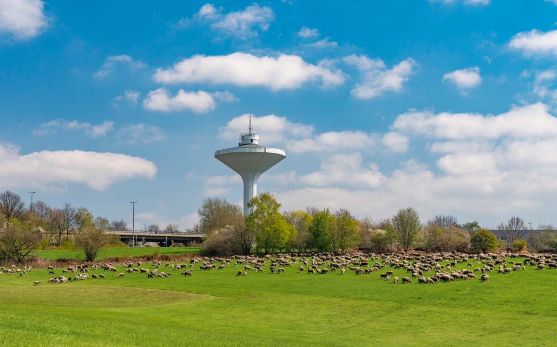
Wuppertal - Neuer Lichtscheider Wasserturm © klaes-images/Holger Klaes
